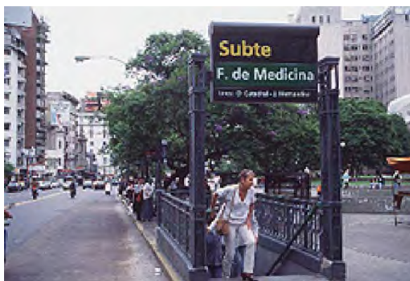
Boca de acceso al subterráneo en Facultad de Medicina.
