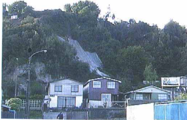
Foto N° 2. Cerro la Pólvara. Sector de alto riesgo ante procesos de remoción en masa.
