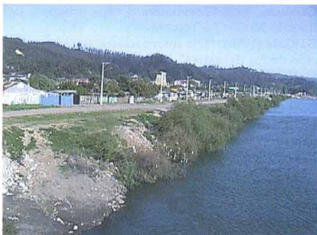
Foto N° 4. Población Pedro Valdivia Bajo. Presenta riesgo extremo frente a inundación fluvial y sismo.
