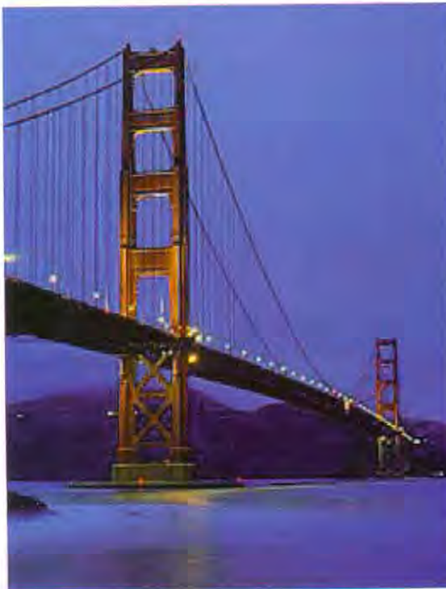
Estructura del Golden Gate en la bahía de San Francisco.
