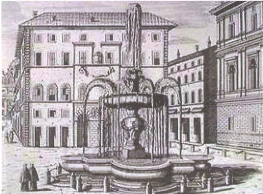
Piazza y fontana en vía de Roma, definidas como punto central urbano.
