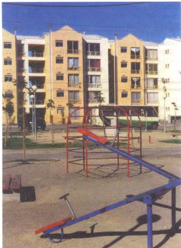
Edificio de Ribera Norte, Concepción.
