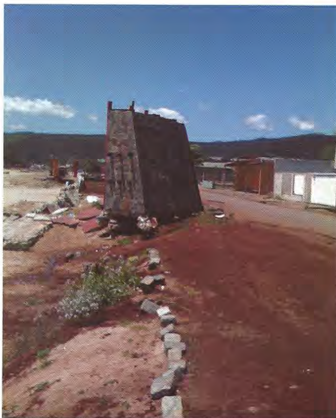
Costanera e instalaciones destruidas después del 27F
