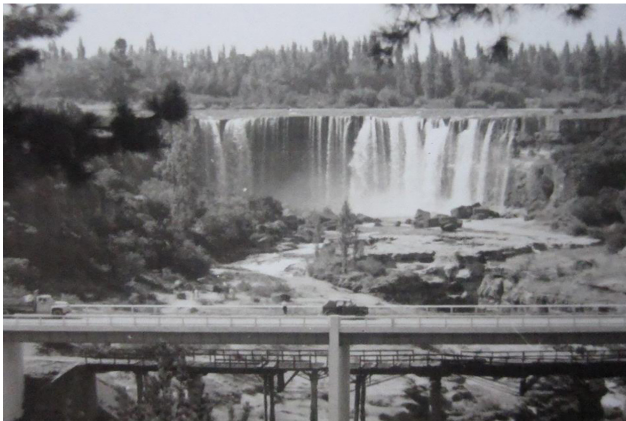
Figura 8. Vista puente nuevo y antiguo, década de 1960. Fuente: [Fotografía], Salto del Lajatur. www.saltodellajatur.cl .
