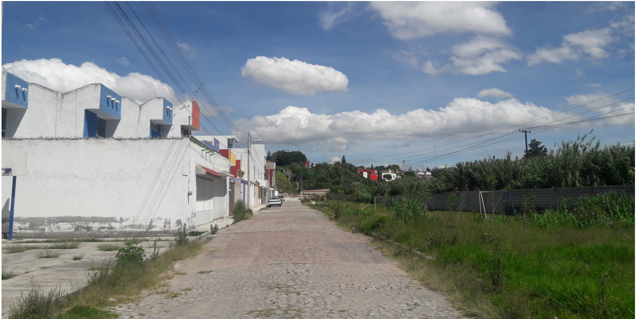
Figura 4. Viviendas en zona de riesgo. Fotografía de la autora, 2017.
