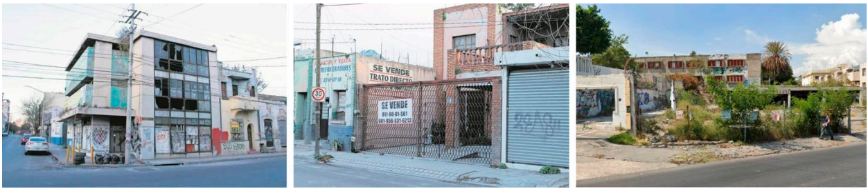
Figura 2. Abandono de la vivienda en CMM. Fuente: Elaboración de los autores con Google Earth Pro.
