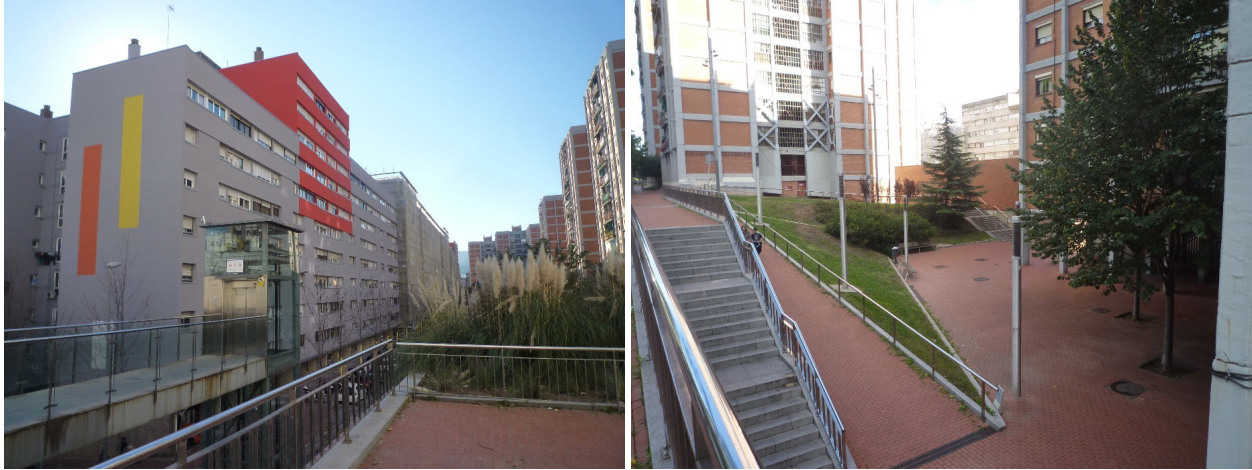
Figura 2. Rehabilitación de un bloque de viviendas y ascensor como ejemplo de mejora de la accesibilidad. Fuente: Elaboración del autor (2019/01/12)
