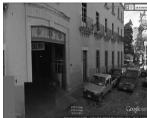
Fig.17. Estacionamientos recientes construidos con fachadas de la época
