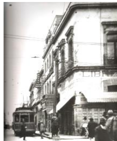
Fig. 8. Deterioro de edificios en el centro histórico
