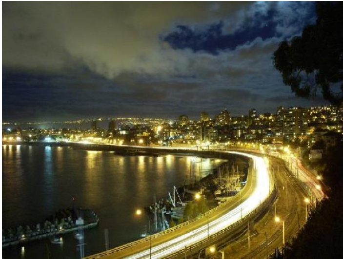
Imagen N° 3: Borde Costero de la ciudad de Viña del Mar, en el sector residencial del Barrio Recreo . En primer plano se observa el Club de Yates Recreo , la Avenida España –que comunica a la Ciudad-Jardín con Valparaíso, y a continuación la antigua línea del ferrocarril que conectaba a la capital regional con el interior del valle del Aconcagua y con Santiago de Chile, hoy vía de comunicación administrada por la Empresa Merval (Metro Regional de Valparaíso). Fuente: gentileza Profesor Pozo, Centro de Cultura Naval y Marítima, 2008.
