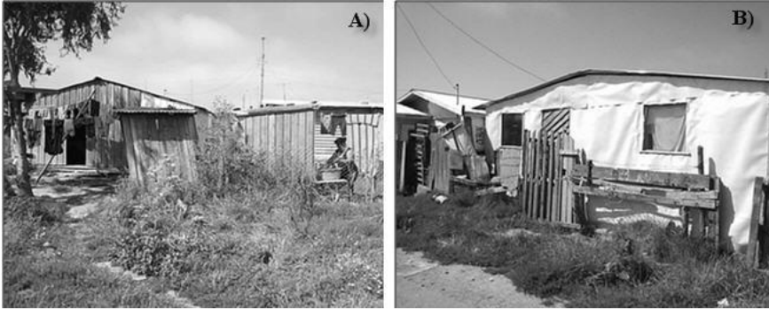
Fig. 4. Vistas panorámicas de la toma de terreno Fresia, Arauco
