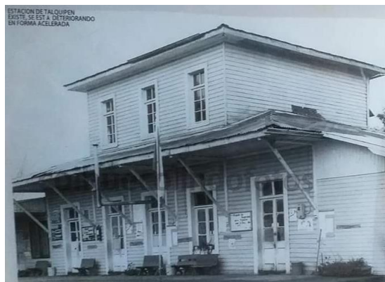
Figura 2. Estación Talquipén antes del cese de funcionamiento. Fuente: Captura propia de foto restaurada por ONG Coihueco Lindo
