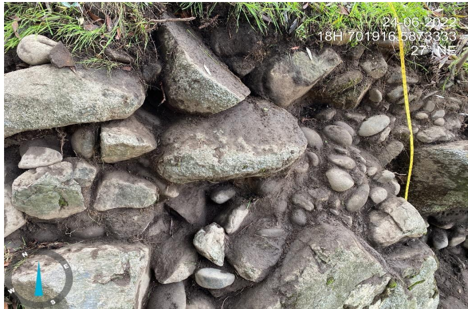
Figura 4. Detalle de la estructura despejada.
