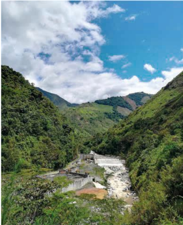
Figura 3. Área de captación de la hidroeléctrica.
