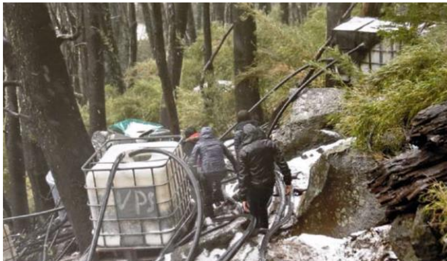
Fotografía 4: Mangueras para el abastecimiento de agua sector Las Trancas Fuente: La Discusión, 29/05/2019
