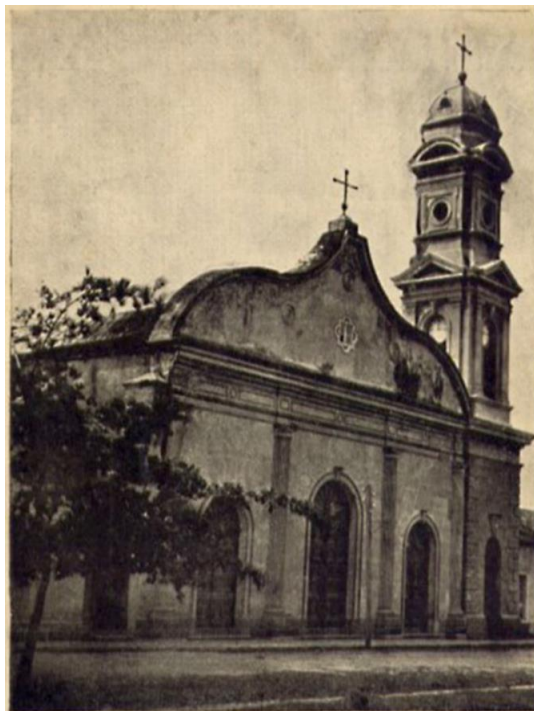
Fotografía 4: Fachada de la parroquia sacada después de 1916.
