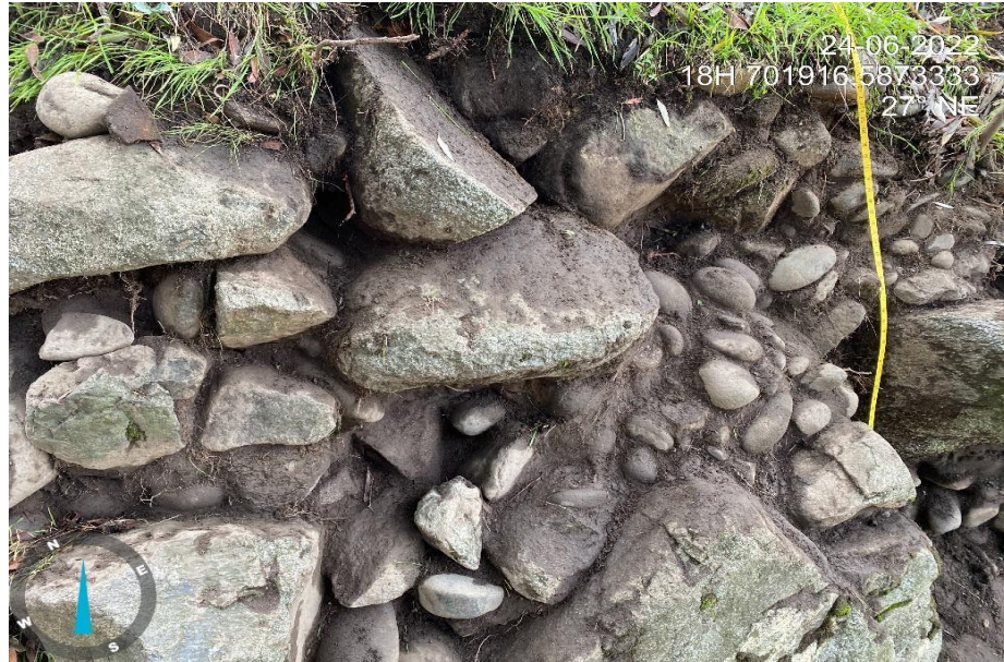
Figura 4. Detalle de la estructura despejada.
