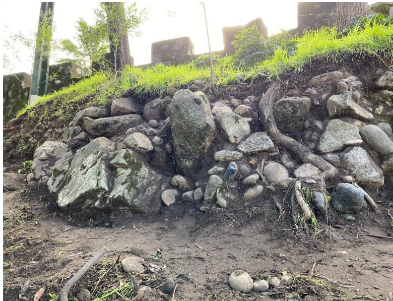
Figura 3. Estructura de piedras posterior al despeje.
