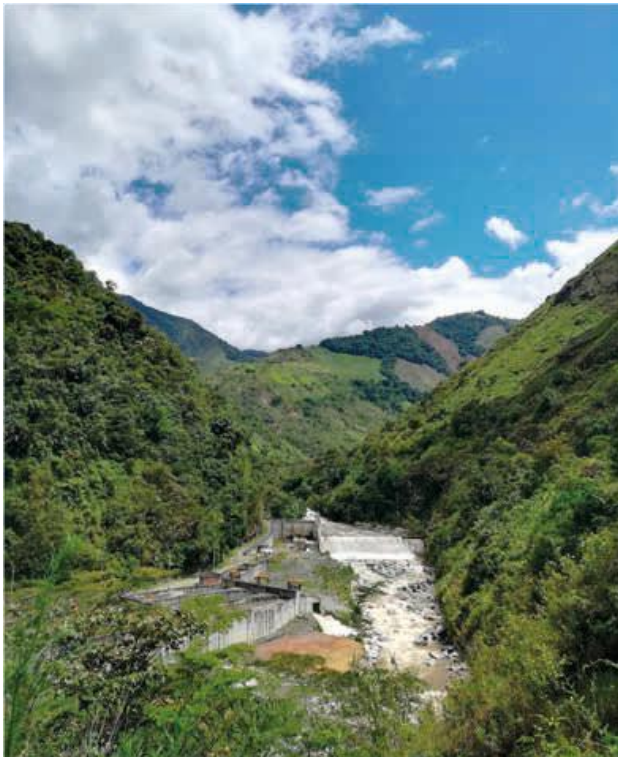
Figura 3. Área de captación de la hidroeléctrica.
